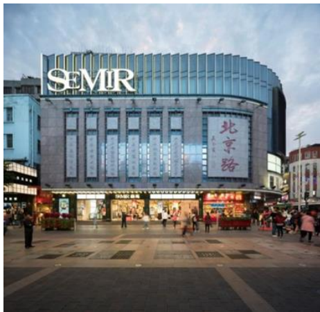
Рисунок 7. Дорога в Пекине после обновления общей пространственной сцены.
