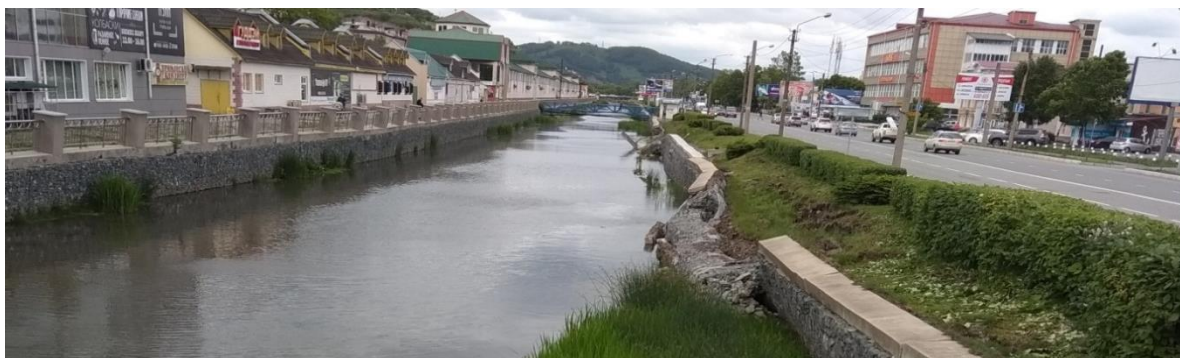
Рисунок 3 – Разрушение берегозащитной стенки из габиона от боковой эрозии на р. Каменка в центре Находки.
