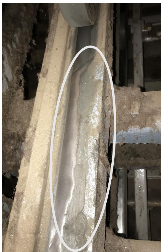
Рис.3. Накат на направляющей бегунка ступени
