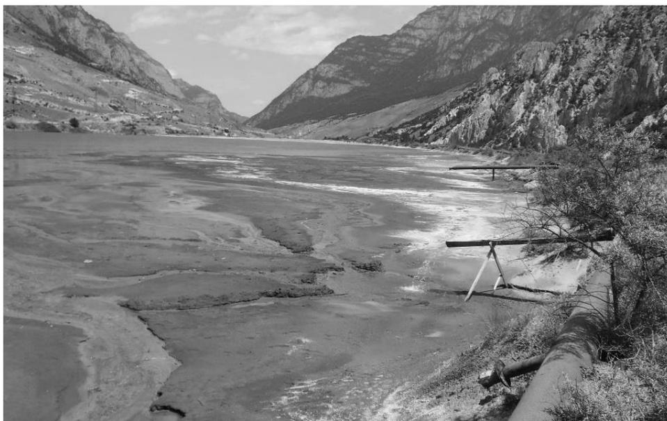
Рисунок 1. Хвостохранилище Мизурской обогатительной фабрики. Вдали горизонтально виднеется водная часть (1), справа: сухая солевая часть (2), на переднем плане и далее справа: открытый сброс «хвостов» в чашу отстойника (3). Фото Дзодзиковой М.Э., 2014 г.
